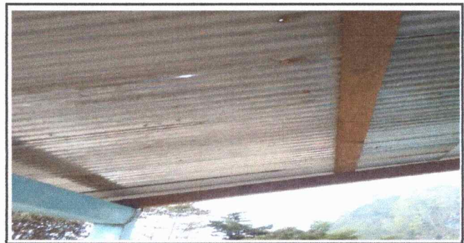
Foto 6: C de lamina y sustitucion de vigas por costanera
