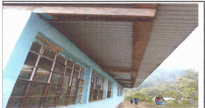
Foto 4: Canales de bajadas de agua pluvial.
